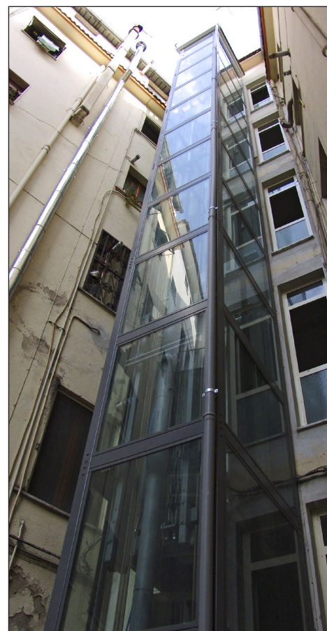
Incastellatura esterna verniciata RAL, chiusa superiormente da un cappello in lamiera coibentata.
