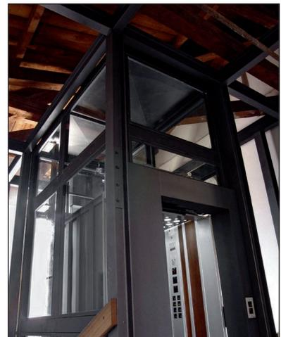
Struttura: incastellatura metallica autoportante per interni, verniciata con smalto antiruggine "effetto antico".
