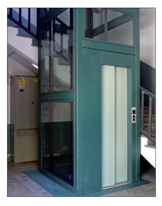
Portale in lamiera di acciaio verniciata RAL. Rivestimento porte esterne in laminato plastico, finitura speciale. Profili in alluminio anodizzato.
