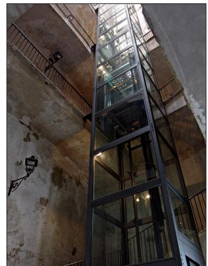
Struttura: incastellatura metallica autoportante per interni, verniciata con smalto anti-ruggine "effetto antico".
